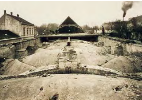
Das Kanalhafengebäude wurde 1928 abgetragen. Blick auf die Gewölbekuppeln im Dachbodenbereich: Dach und Dachstuhl waren bereits entfernt worden.
