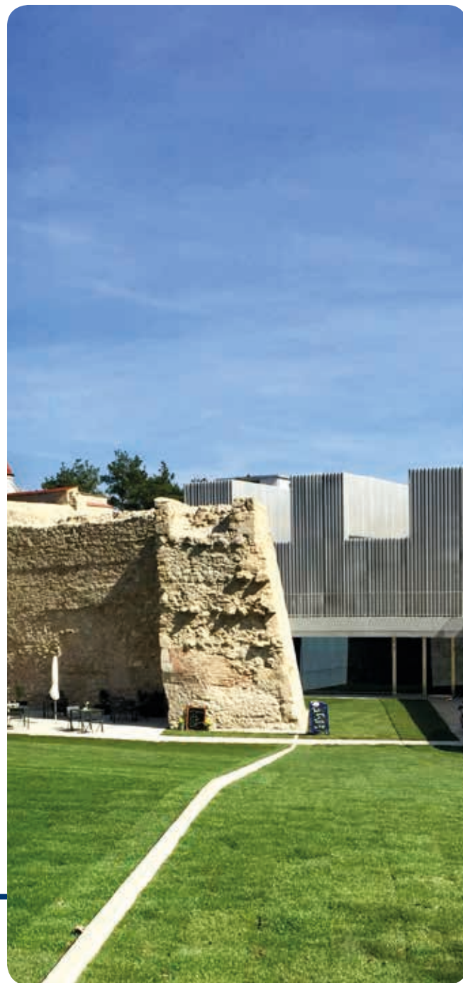
Die Kasematten mit der Alten und Neuen Bastei © Magistrat Wiener Neustadt, Michael Weller
